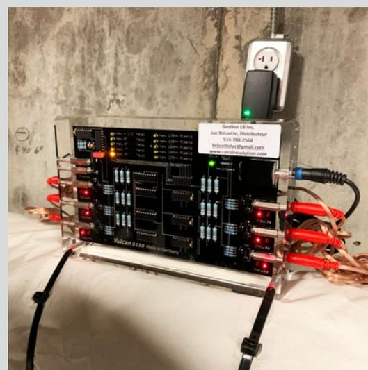
Vulcan S10 a été installé sur les conduites de circulation d'eau chaude au 27<sup>e</sup> étage. Avant l'installation de Vulcan, les bandes à courant d'impulsion ont été recouvertes en vue d'éviter la condensation.
