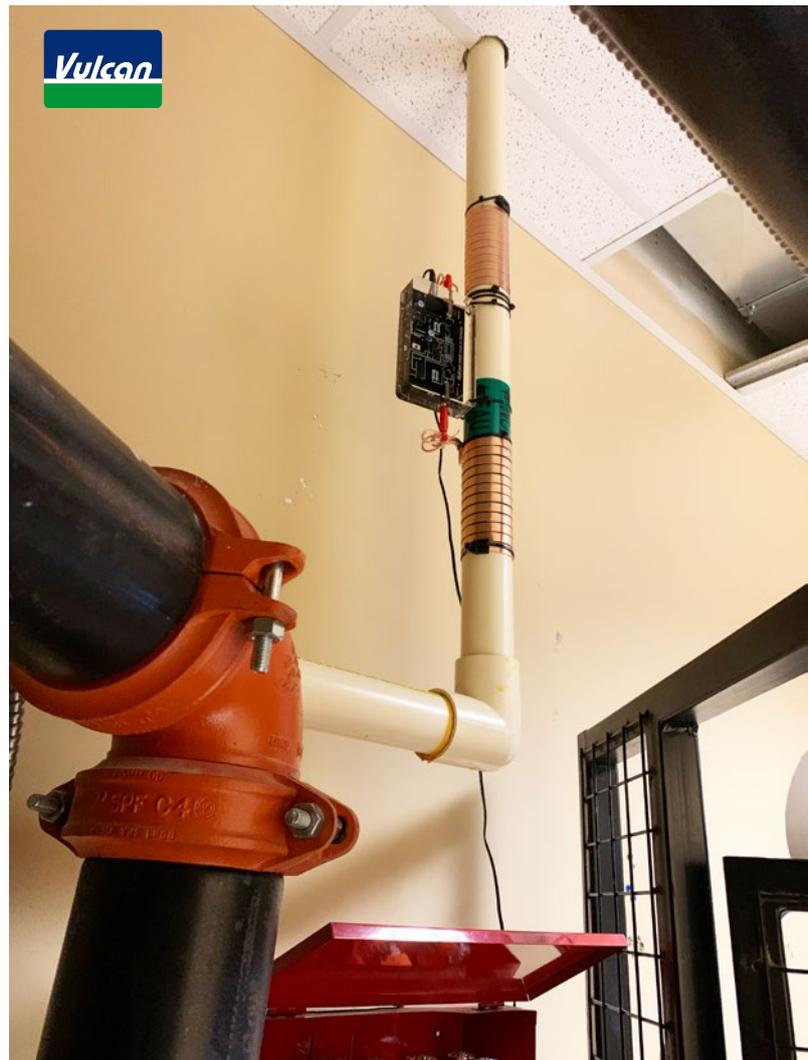
Vulcan 5000 a été installé sur la conduite d'eau principale du système de canalisation.
